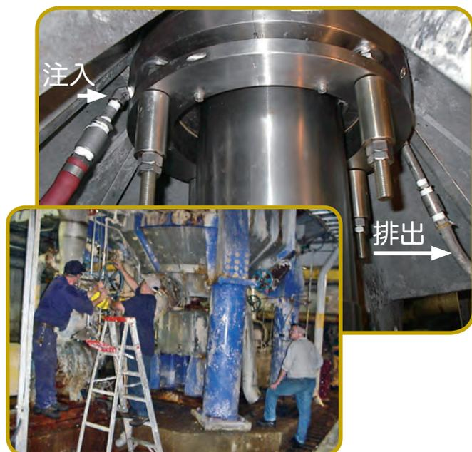
ボトムエントリーの300mm軸のパルパーに取り付けられたEPタイプ1シール
